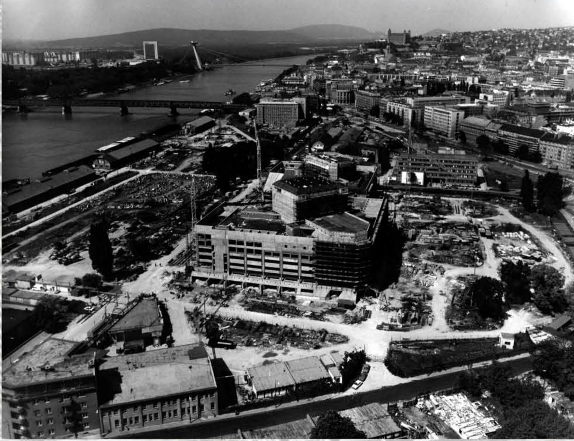
Budova SND počas výstavby, 90. roky. Realizácia stavby v rokoch 1986-2007
